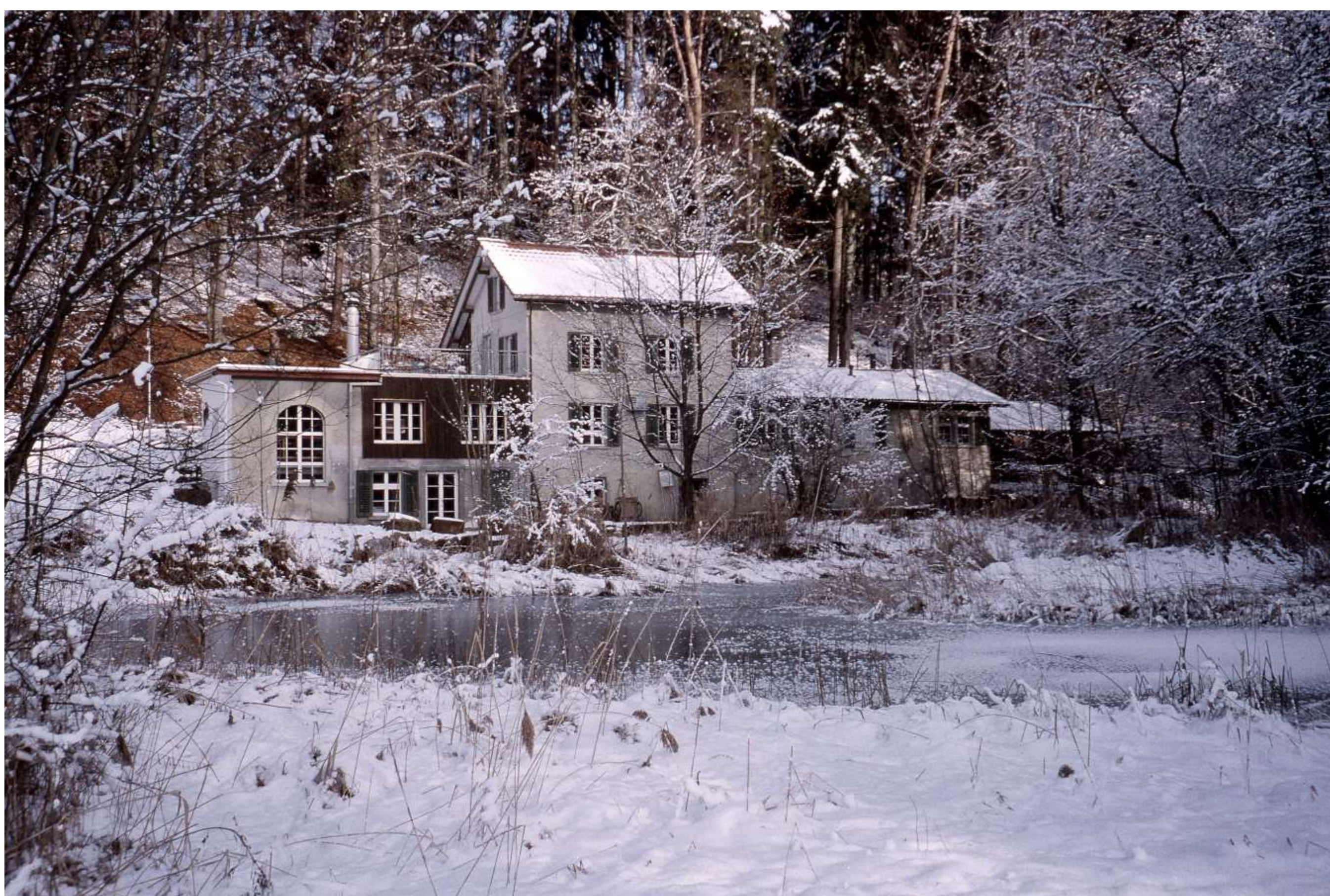
Pfadiheim Weierholz nach der Inbetriebnahme.
